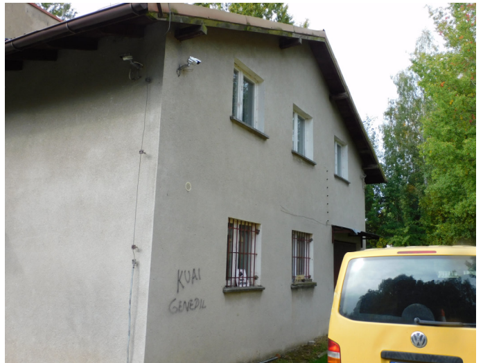
Elewacja zachodnia uszkodzenia spękania filarek między okiennych oraz rejonie węzłów oparcia nadproży okiennych
