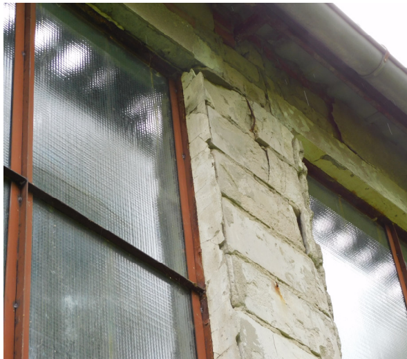
Elewacja zachodnia uszkodzenia spękania filarek między okiennych oraz rejonie węzłów oparcia nadproży okiennych
