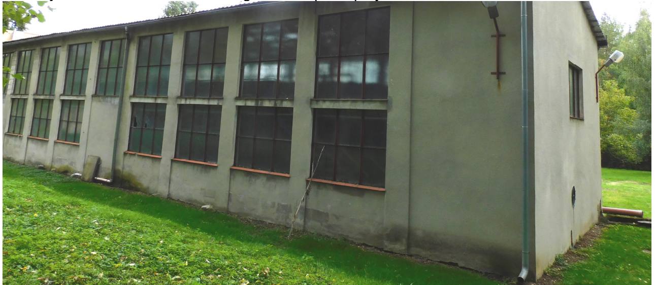
Elewacja zachodnia -widoczne zawilgocenie w pasie przyziemia
